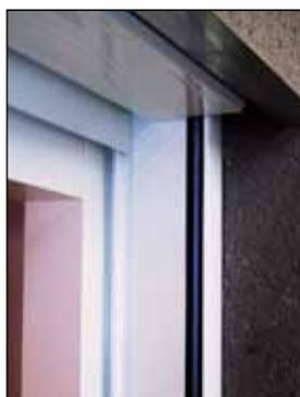
Im Schacht mit Clip Softführungs-schiene
